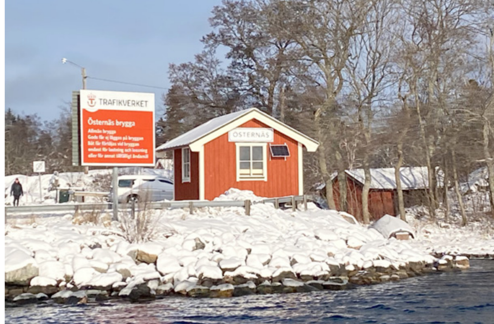
Välkomnande och värmande ligger det nu där, det lilla vänthuset vid Östernäs brygga. Foto: Malin Lenke
