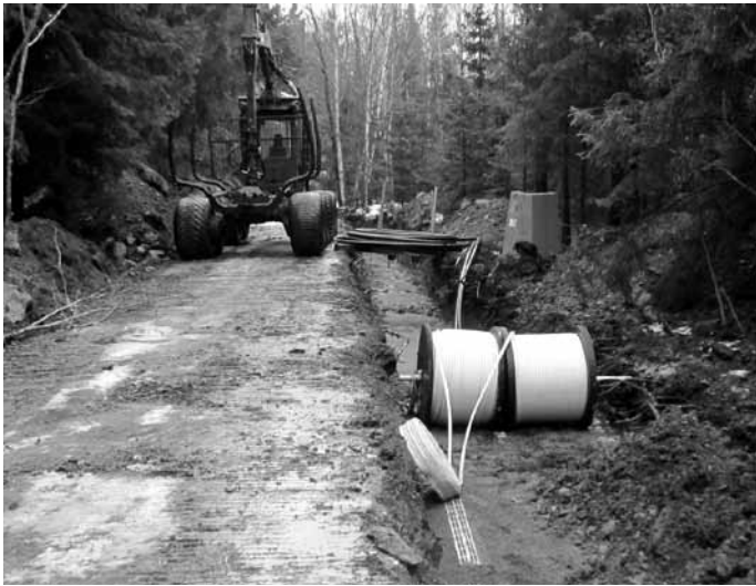
Skogsmaskinen håller ordning på slangarna eller röjer skog inför schaktning.
