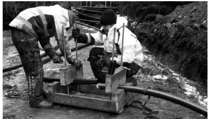
Svetsning av skarv på avloppsslang
