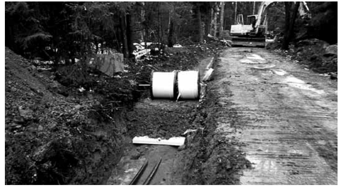
Samförläggning av VA, el och fiber som läggs i olika lager i schakten
